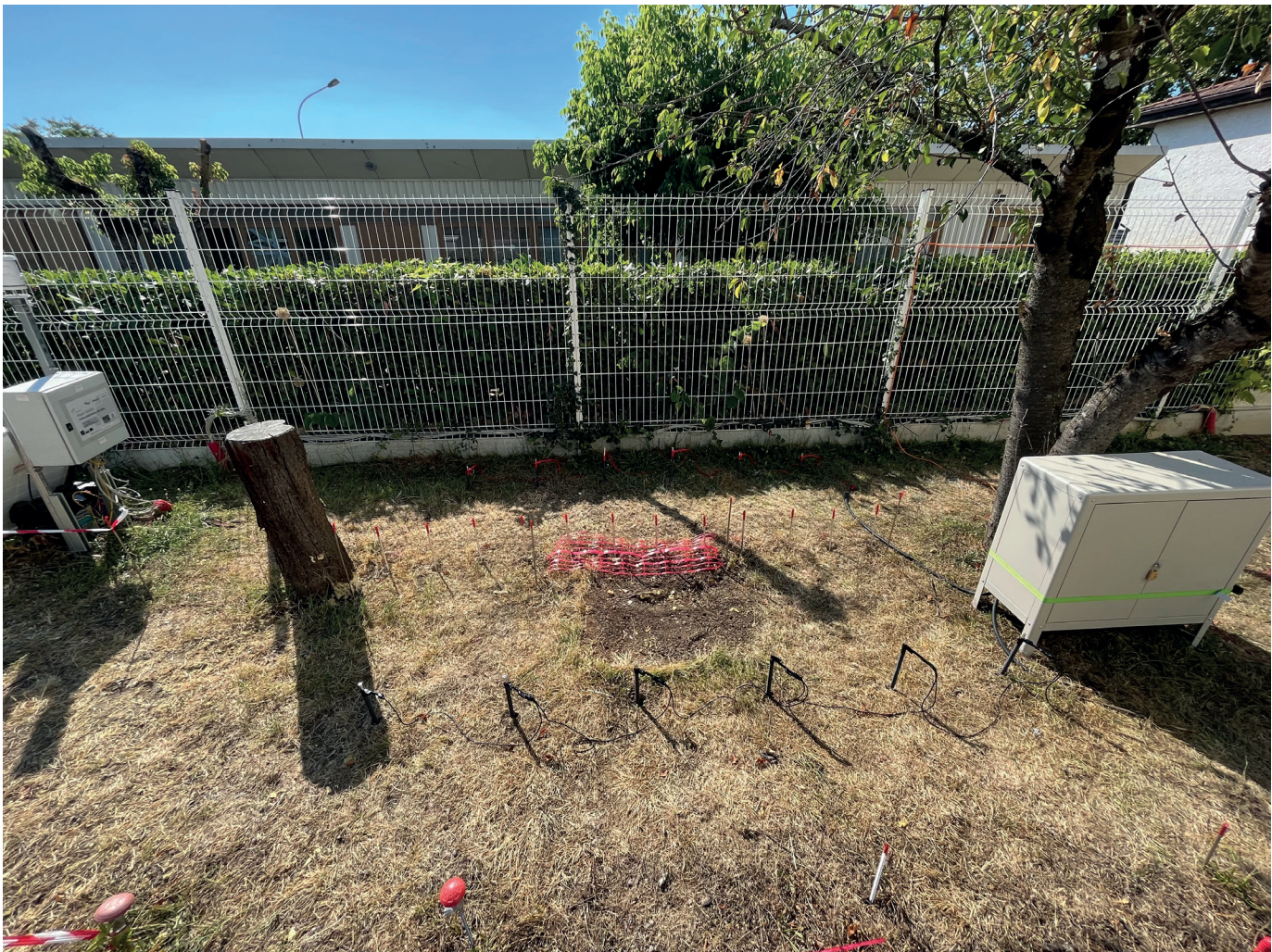
Photo 6 : Installation sur le site de Cornebarrieu
