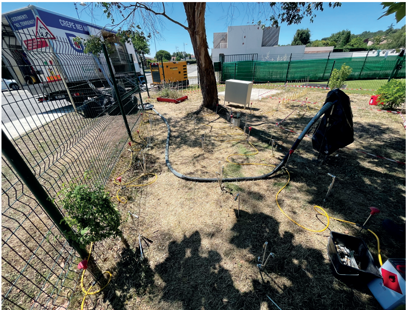
Photo 4 : Installation sur le site de Labège
